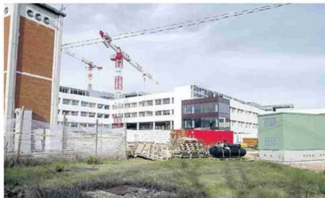
I lavori in corso all'ospedale a Campitello di Fermo
