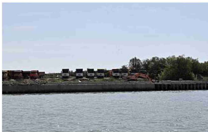
L'isola dei fanghi All'isola delle Tresse vengono stoccati i fanghi scavati in laguna
