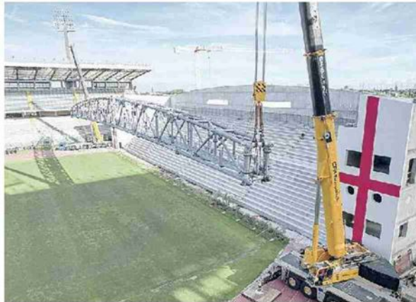
L'INDAGINE Il cantiere era stato sequestrato lo scorso novembre
