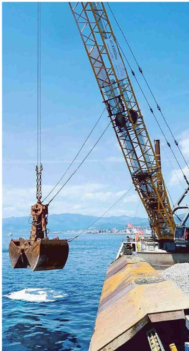
I lavori per testare i fondali dove sarà costruita la nuova diga
