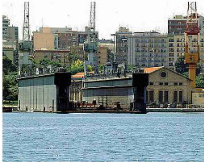
Il luogo Una veduta dal mare dell'Arsenale della Marina militare
